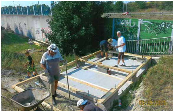
Gemeinsam wurden das Fundament und darauf der Unterbau hergestellt.
