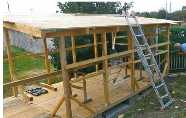
...und die Anbringung der Dachbretter.
