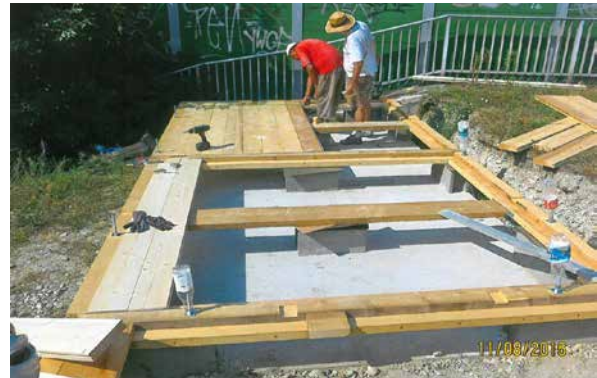
Nach der Verlegung des Bodens ...
