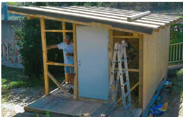
Die Schwarzdeckung des Daches und die Eingangstür kam als nächstes an die Reihe, ...
