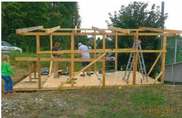
... ging es an die Errichtung des Grundgerüsts ...
