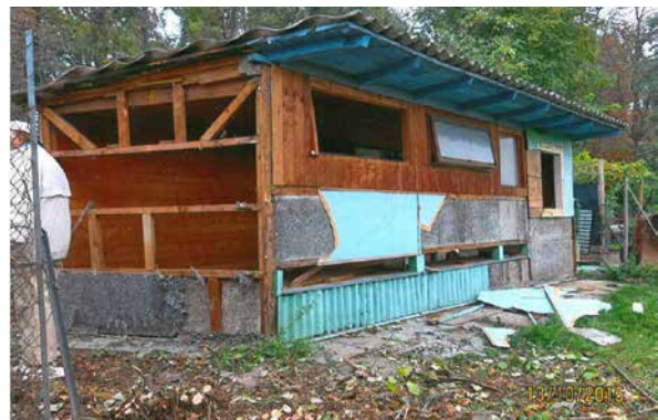
... denn jetzt kann der Abbruch der alten Hütte erfolgen.
