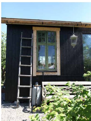
Nathalie und Foreting benutzen die mehrere hundert Jahre alte japanische Shou-sugi-ban-Methode für die Fassade. Das Holz wurde zuerst verbrannt und dann mit Öl behandelt. Die-Shou-sugi-ban-Methode macht das Holz grundsätzlich wartungsfrei.
