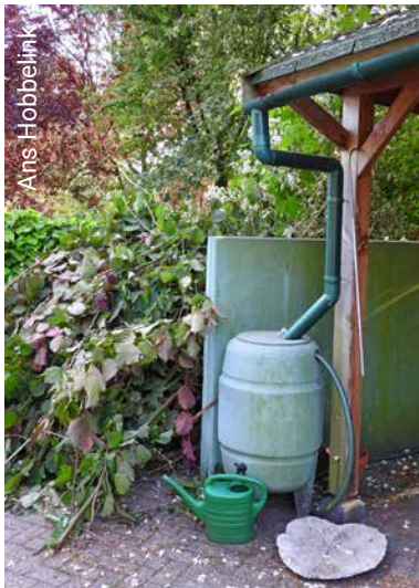
Dieser Unterstand wird zum Sammeln von Regenwasser genutzt.
